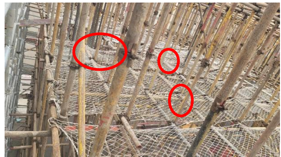
（图2）立杆对接接头在同一截面
