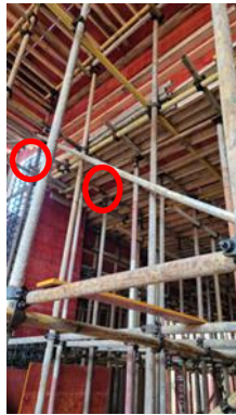
（图1）竖向剪刀撑与立杆未用扣件连接
